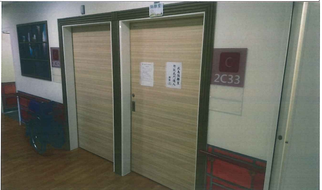
裝修工程-長照教學大樓門框實木線板工程
