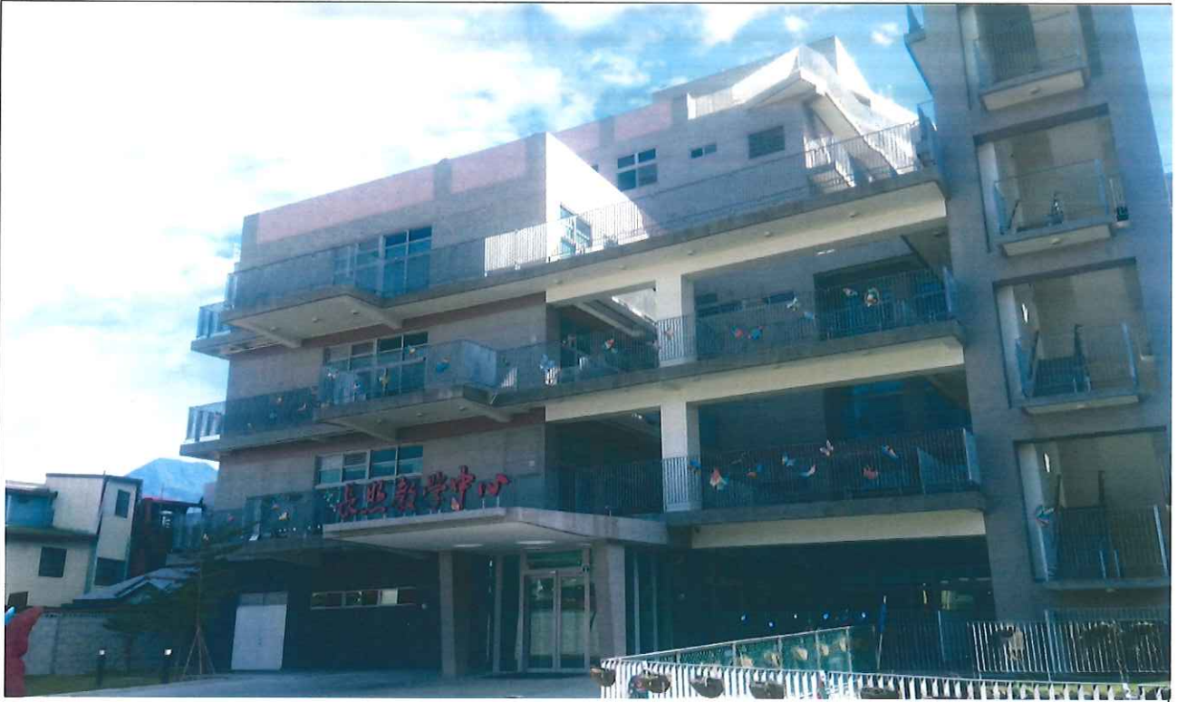
建築工程-長照教學大樓新建工程-土建第23期
