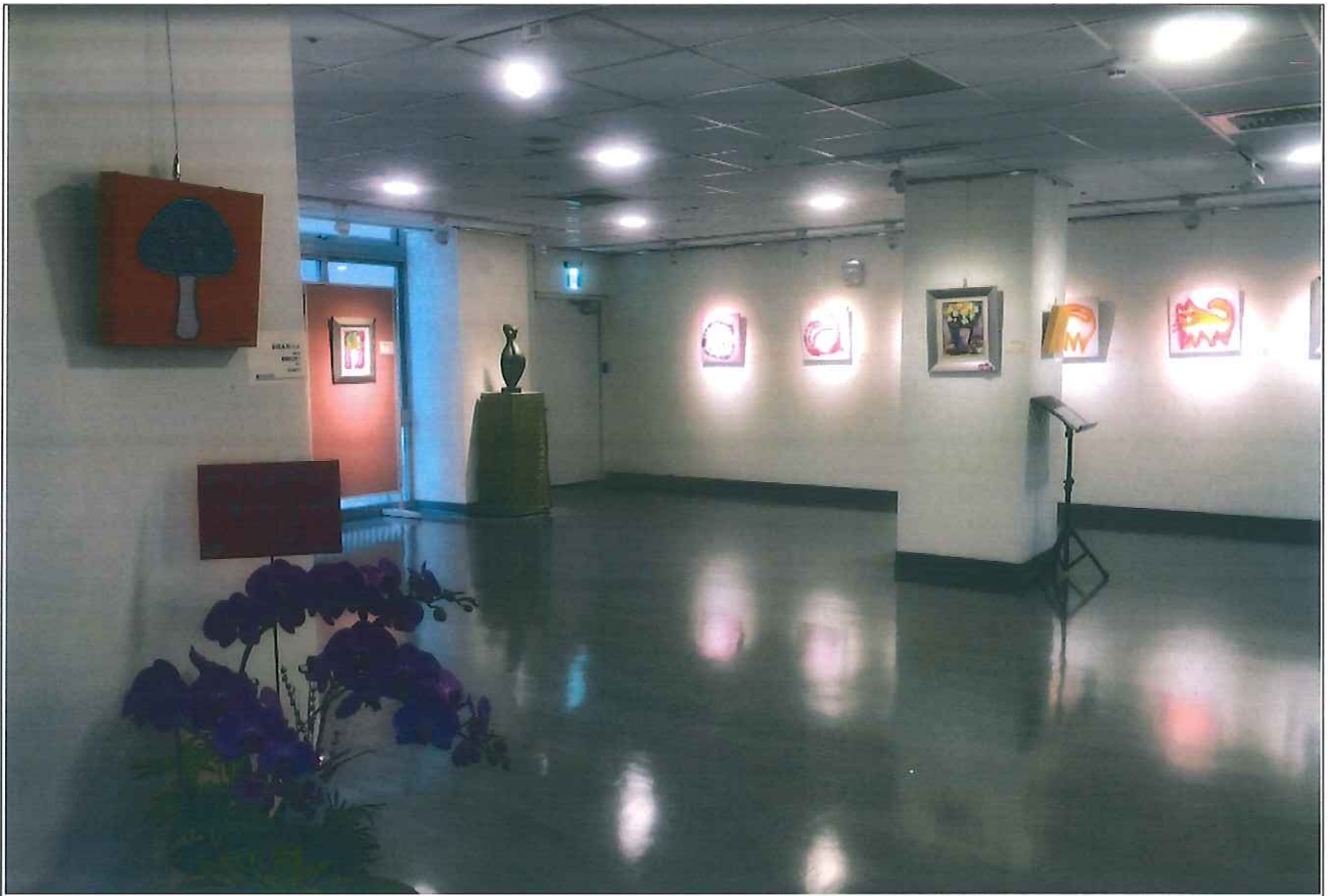
裝修工程-長照教學大樓 B1 展覽室工程
