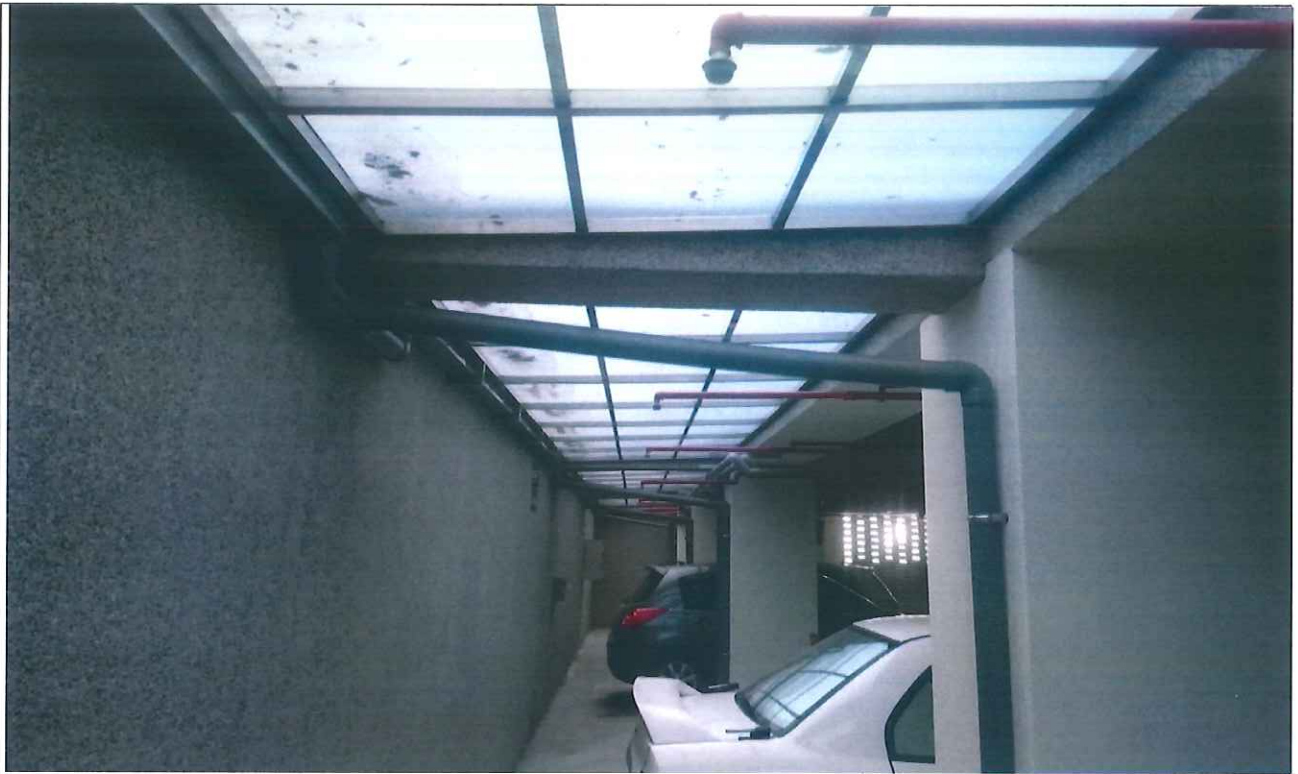
建築工程-長照教學大樓地下室採光罩工程
