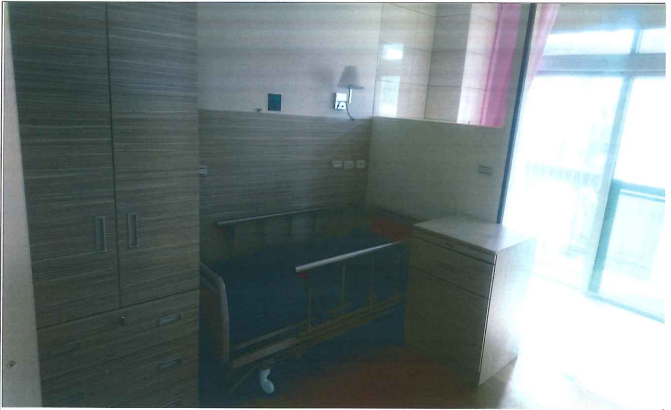
裝修工程-長照教學大樓室裝工程
