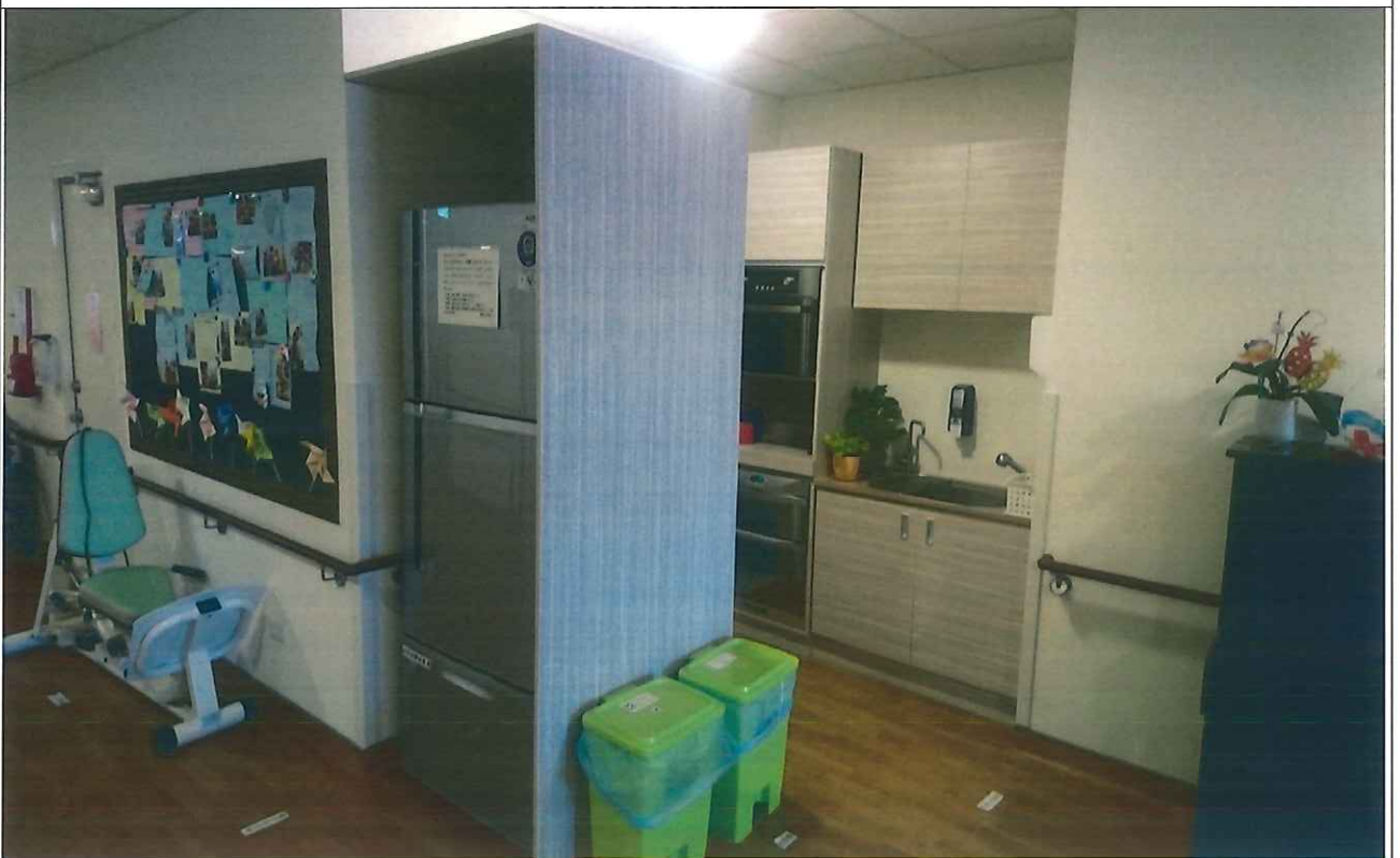
裝修工程-長照教學大樓隔離室隔離櫃工程
