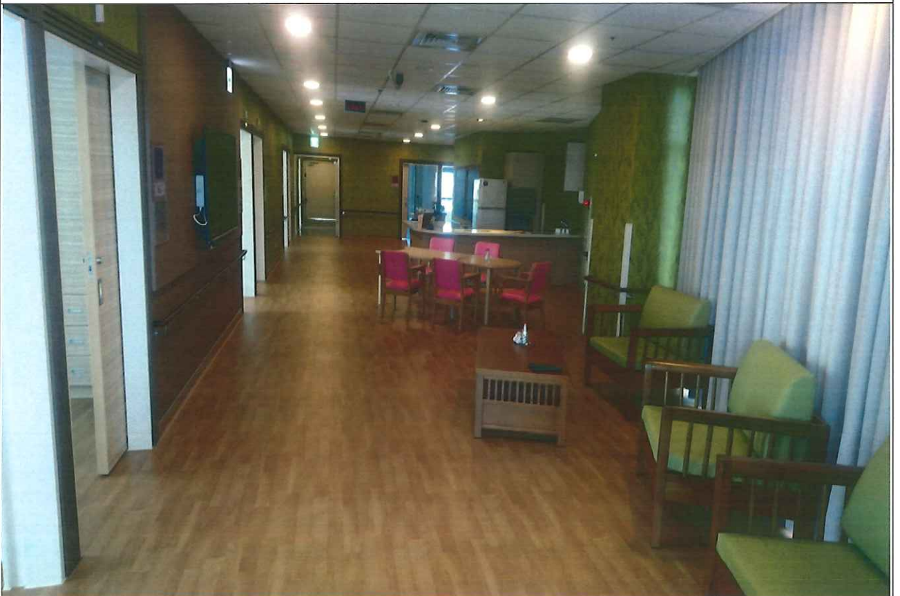
裝修工程-長照教學大樓室裝工程
