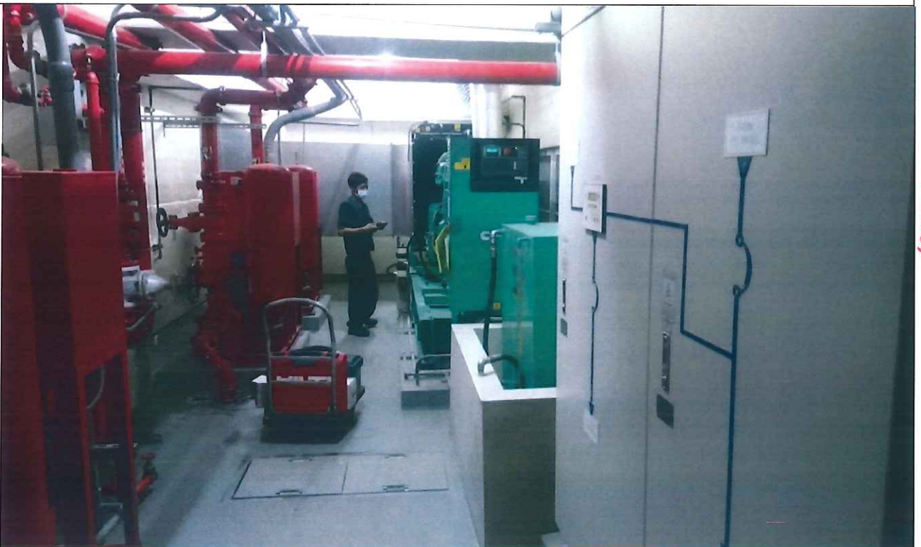
機電工程-長照教學大樓新建工程第21期機電工程款
